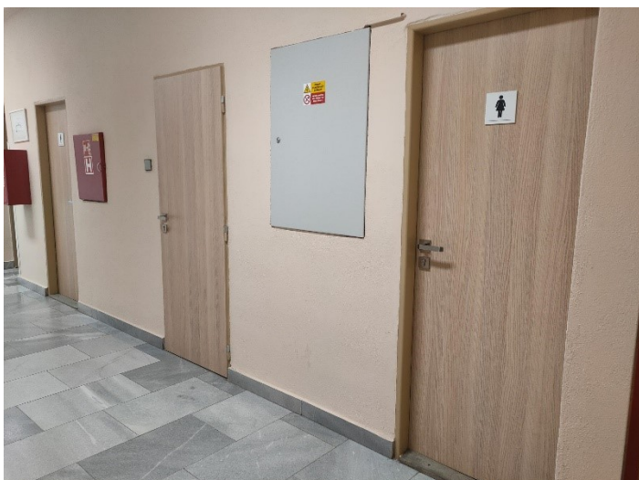
Nové dveře u toalet na budově Fórum
